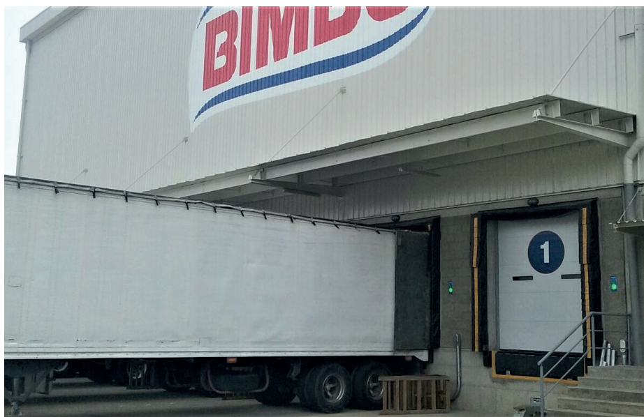
Capa de Lona Removible Novedoso Sistema de Capa Externa REMOVIBLE Para Intercambiar en caso de daño o Averia, sin cambiar todo el sello.
